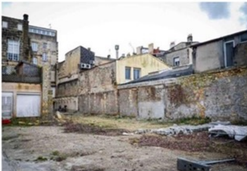
Des travaux avaient débuté sur l'une des parcelles, à l'arrière du 85 quai des Chartrons. Tout a été arrêté. >>> www.lapresse.fr
